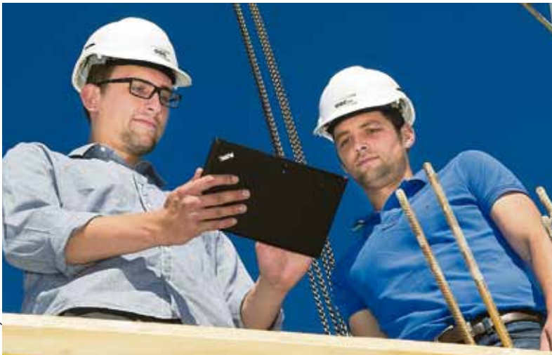
Mit mobiPlan lassen sich Baustellenaktivitäten oder Mängel zeitgemäß dokumentieren.
